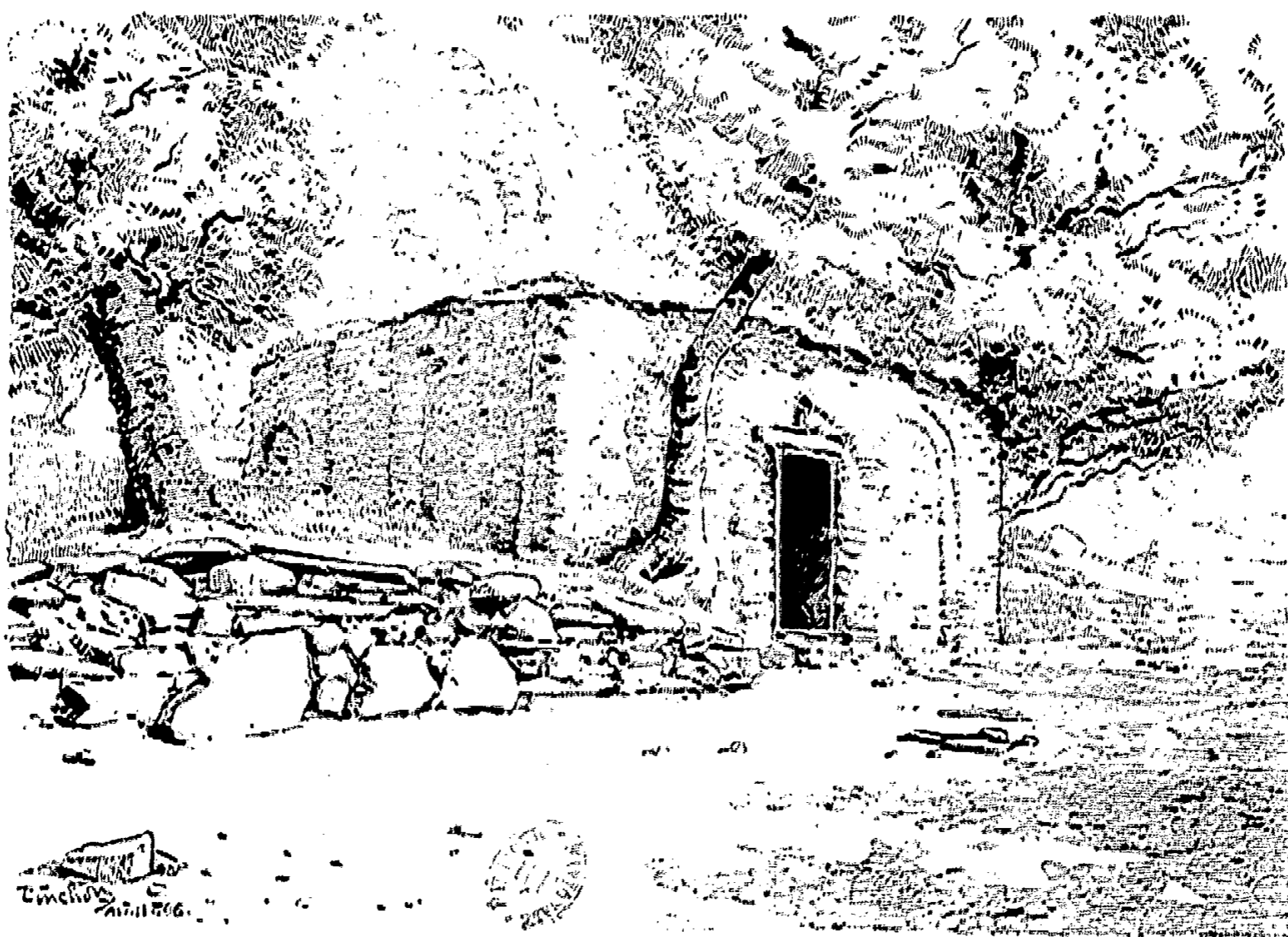
Façade du côté nord de la Maison de la sainte Vierge.
