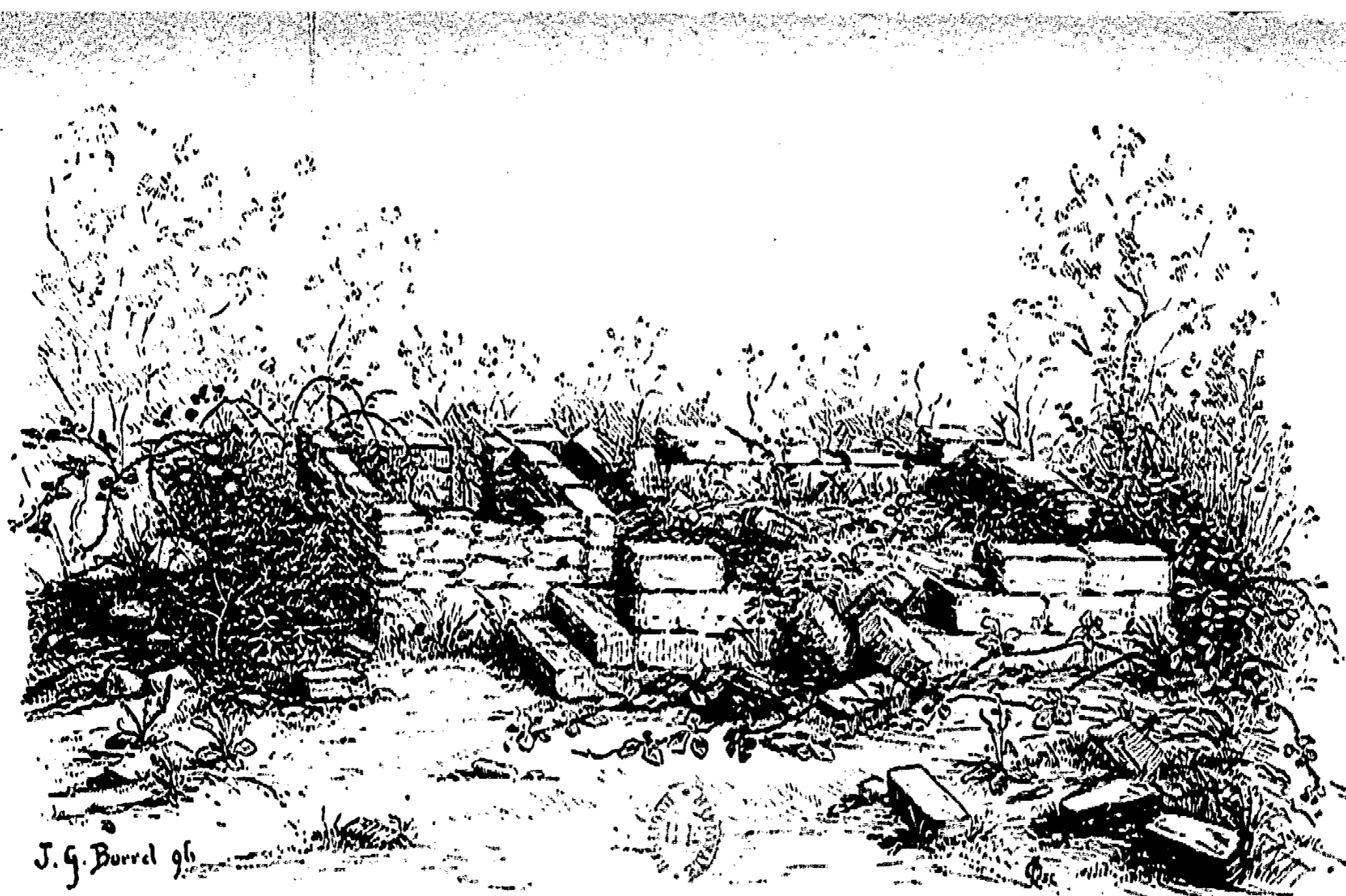
Ruines de la partie centrale du vieux Château.
